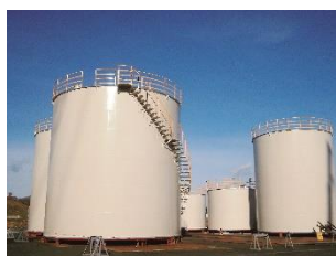
現地組タンク 伊藤製缶工業株式会社
